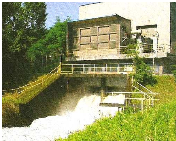
Fot. 1. Elektrownia wodna w Skawinie [9]
