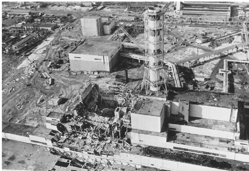
Rys. 4. Widok z helikoptera na uszkodzony blok nr 4
